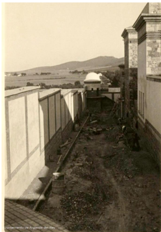
Obras en muro prisión provincial “nueva”
