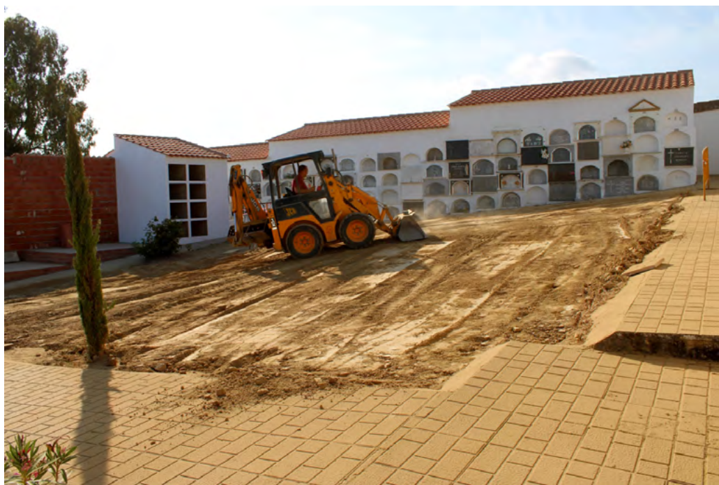
Figura 7. Vista de los trabajos mecánicos que vuelven a cubrir el área intervenida una vez finalizada la excavación y exhumación de las fosas clandestinas localizadas.
