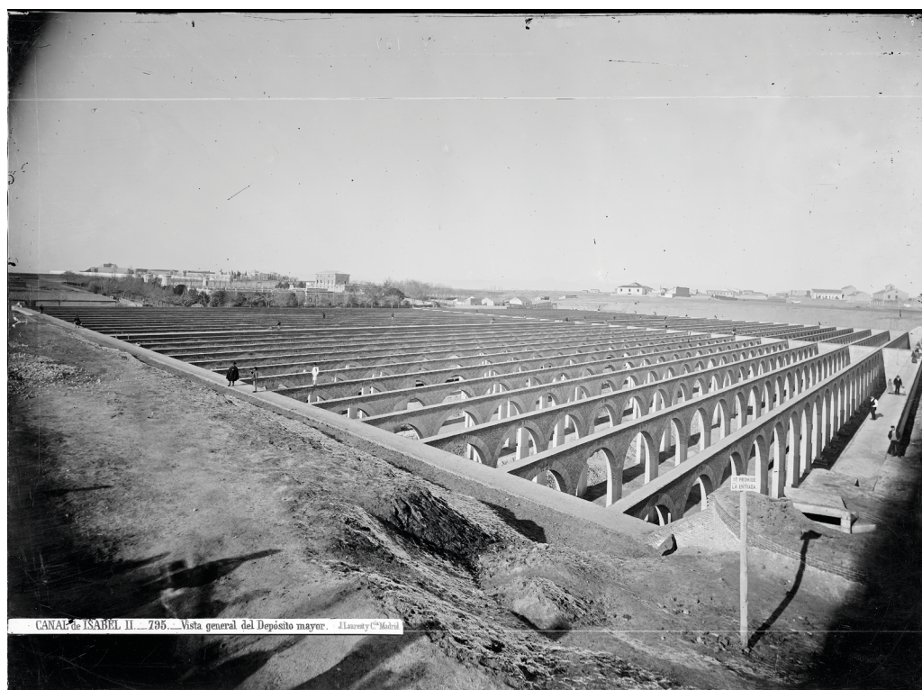
Fig. 5. Vista General del depósito mayor, Jean Laurent, ha. 1875. IPCE, VN-20588_P.
