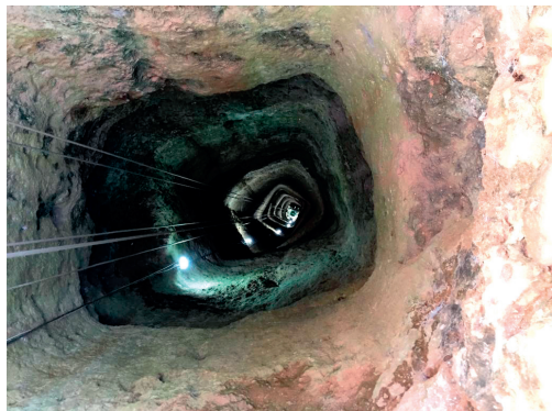
Figura 3. Vista del interior del pozo.
