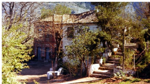
Fotografía 4. Estado de la Colonia de Víznar en un momento previo a su demolición.
