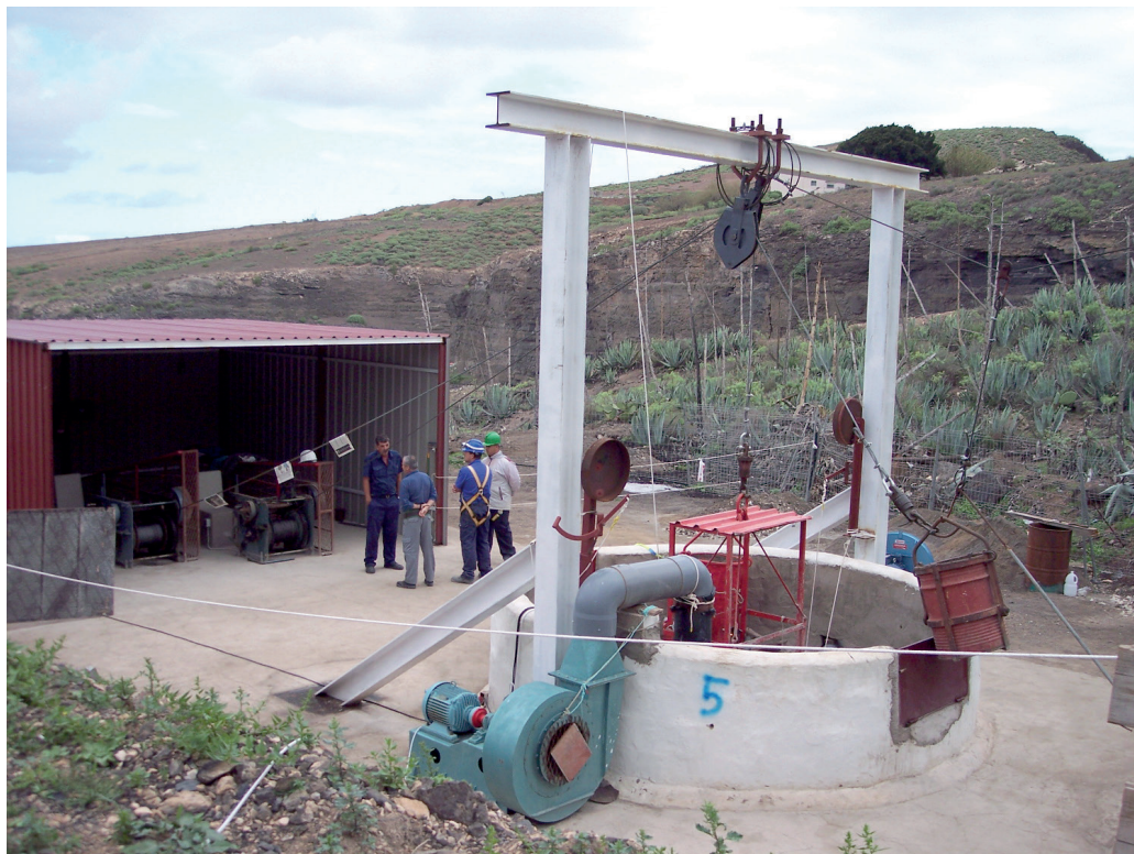
Imagen 48. Vista general de parte de las instalaciones provisionales, con el pórtico en primer plano.
