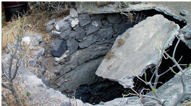
Imagen 42. Vista de la antigua losa de hormigón y de los hastiales del pozo.
