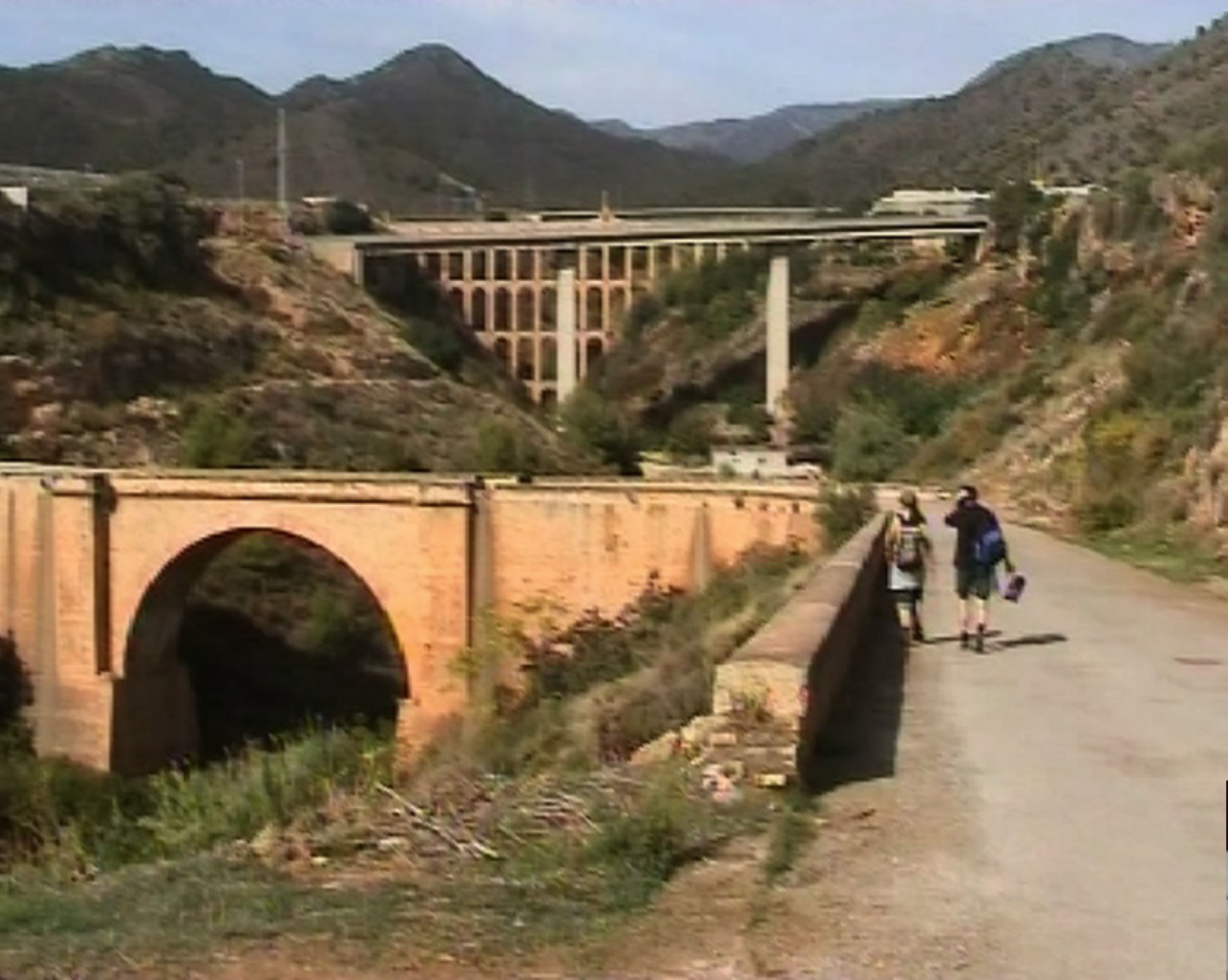
Vista de la carretera. Málaga 1937. Fotograma de vídeo. (RLC 2007)
