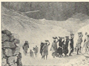
Muchachos egipcios transportando los escombros del lugar de las excavaciones hasta el vertedero.
