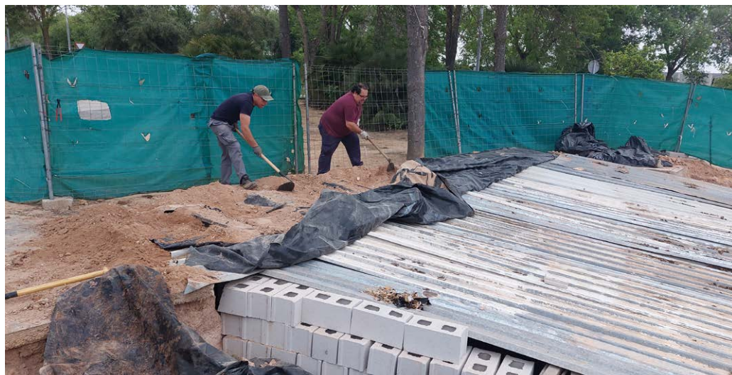
Fig.4.17. Retirada de la cubierta de la Fosa 1 para poder proceder a los trabajos exhumatorios.
