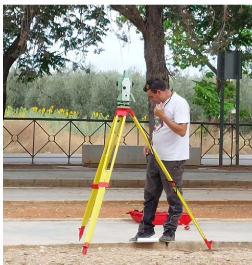
Fig. 4.11 y 12. Imágenes de los trabajos preparativos para topografía y georreferenciación.
