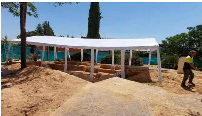
Fig. 4.4. Adecuación, vallado perimetral y cubrición. Espacio Fosa 1.
