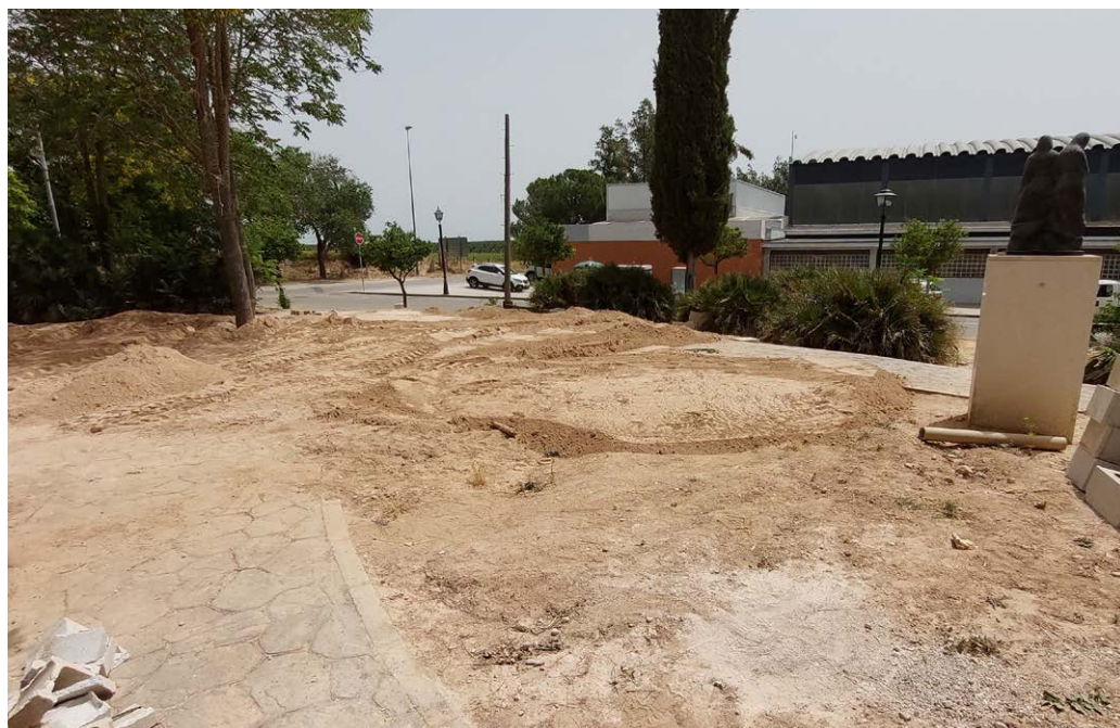
Fig. 4.36. Imagen del área donde se localizaba la Fosa 1, una vez concluidos todos los trabajos.
