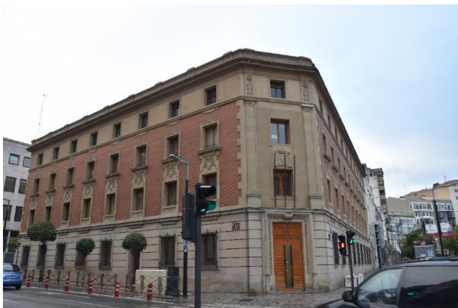
Edificio del antiguo Palacio de Justicia en Logroño
